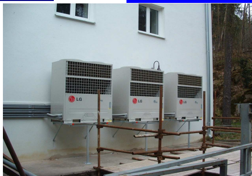
Příklad instalace topného výkonu 100kW
